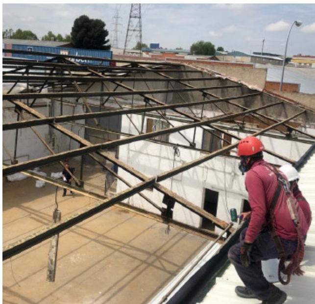
NAVE INDUSTRIAL Fuenlabrada | MADRID
